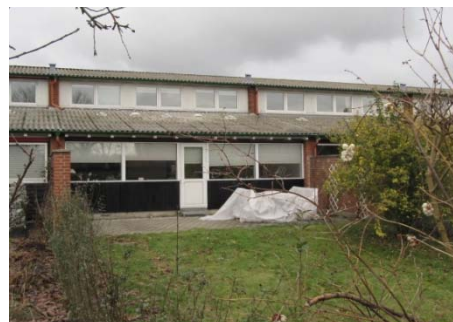
Oprindelig facade mod syd.
