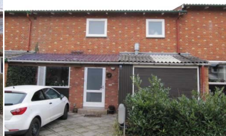
Overdækning langs nordfacaden.
