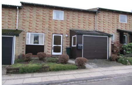
Oprindelig facade mod nord.
